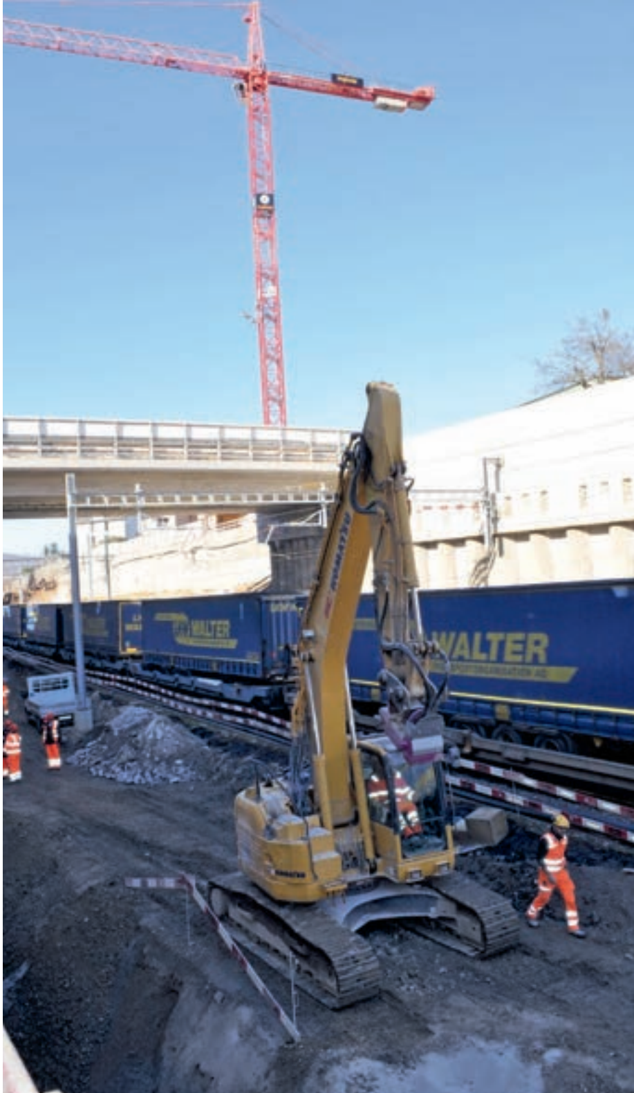
Wenige Meter daneben fahren in regelmässigen Abständen die Züge durch.
