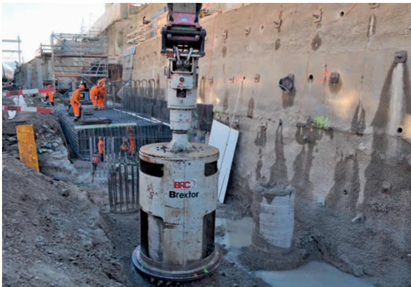
Unter engsten Platzverhältnissen kam der Brextor in Liestal zum Einsatz.
